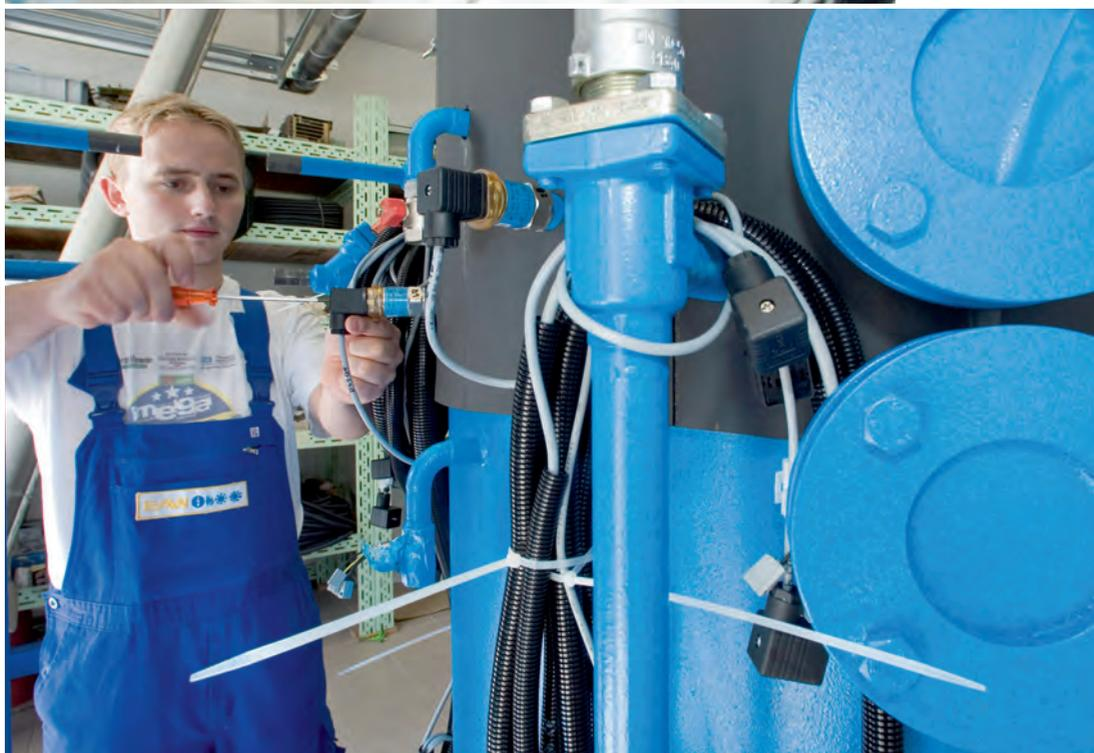
Ein Lehrling justiert eine Absorptionskälteanlage, die aus Solarwärme Kälte gewinnt. Auch bewährte Branchen wie das Sanitärgerwerbe brauchen neue, gut ausgebildete Kräfte.
