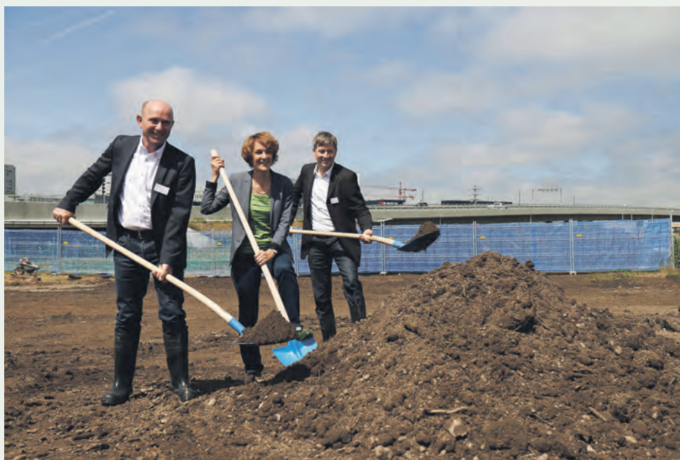
Spatenstich für den neuen Entsorgungshof Schermen.
