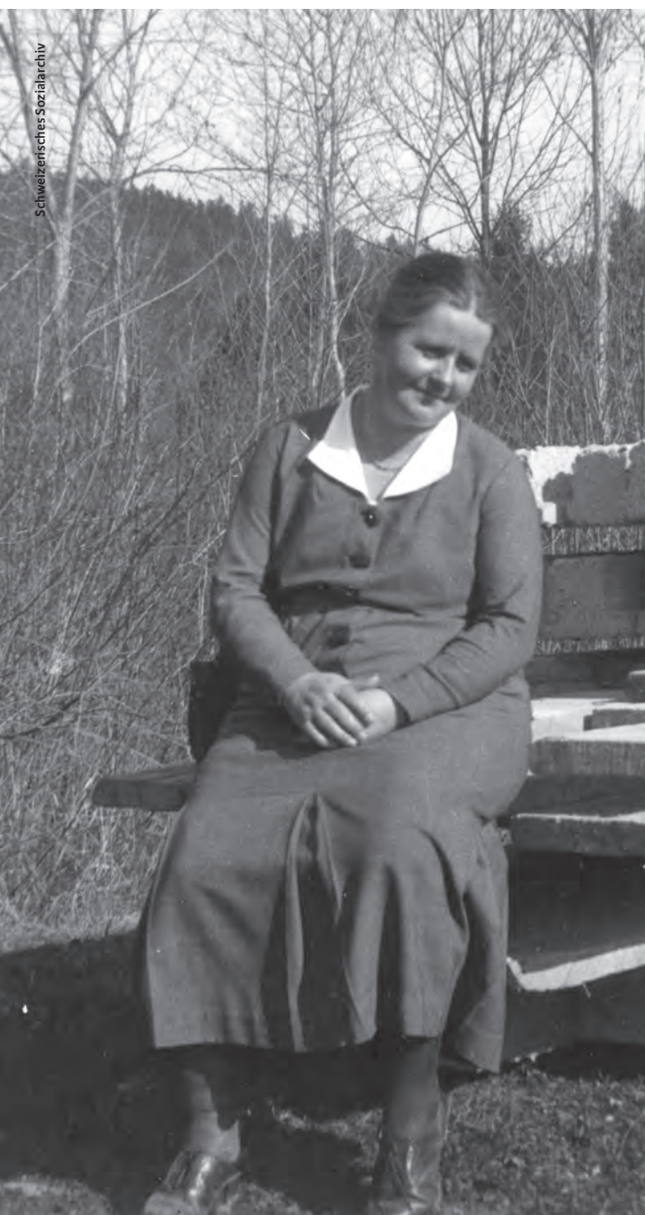
Anny Klawa-Morf, éponyme de la fondation, en 1934/35 sur le chantier de la « Hüsi », la maison des Kinderfreunde Bern (Rote Falken Bern), à Belp.
