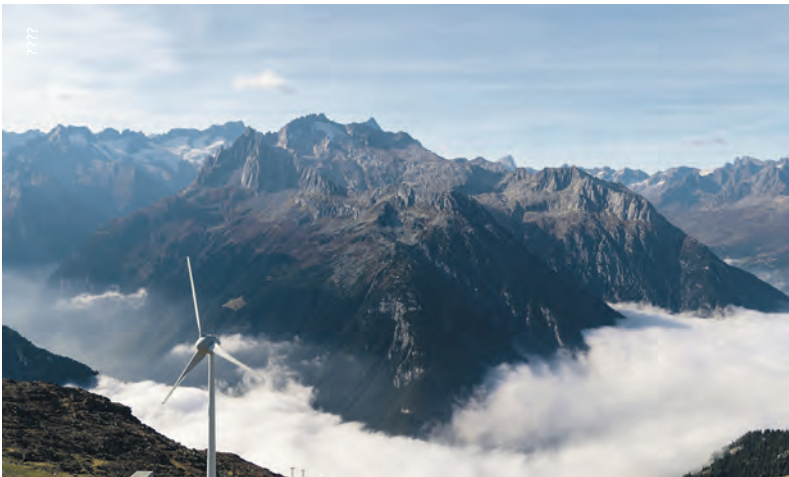
Parc éolien alpin de Gütsch, région d'Andermatt.
